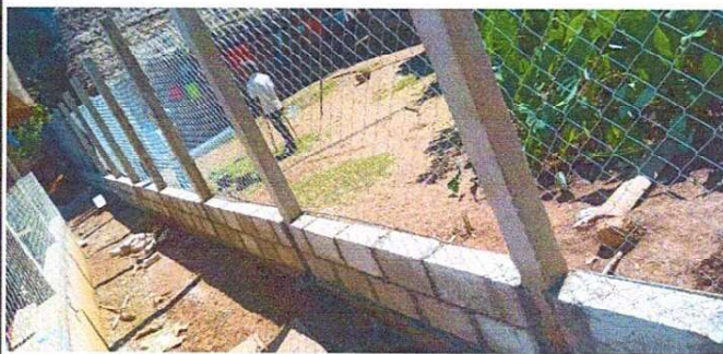
Foto 3: SE OBSERVA LA FINALIZACION DEL MURO PERIMETRAL. MODULO 2
