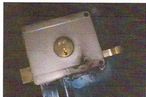
Foto 6: SE OBSERVA LA FINALIZACION DEL CAMBIO DE CHAPAS DE PUERTAS. MODULO 2
