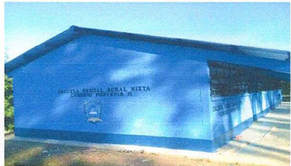
Foto 2: SE OBSERVA LA FINALIZACION DE PINTURA EN PARED Y PUERTAS. MODULO 1
